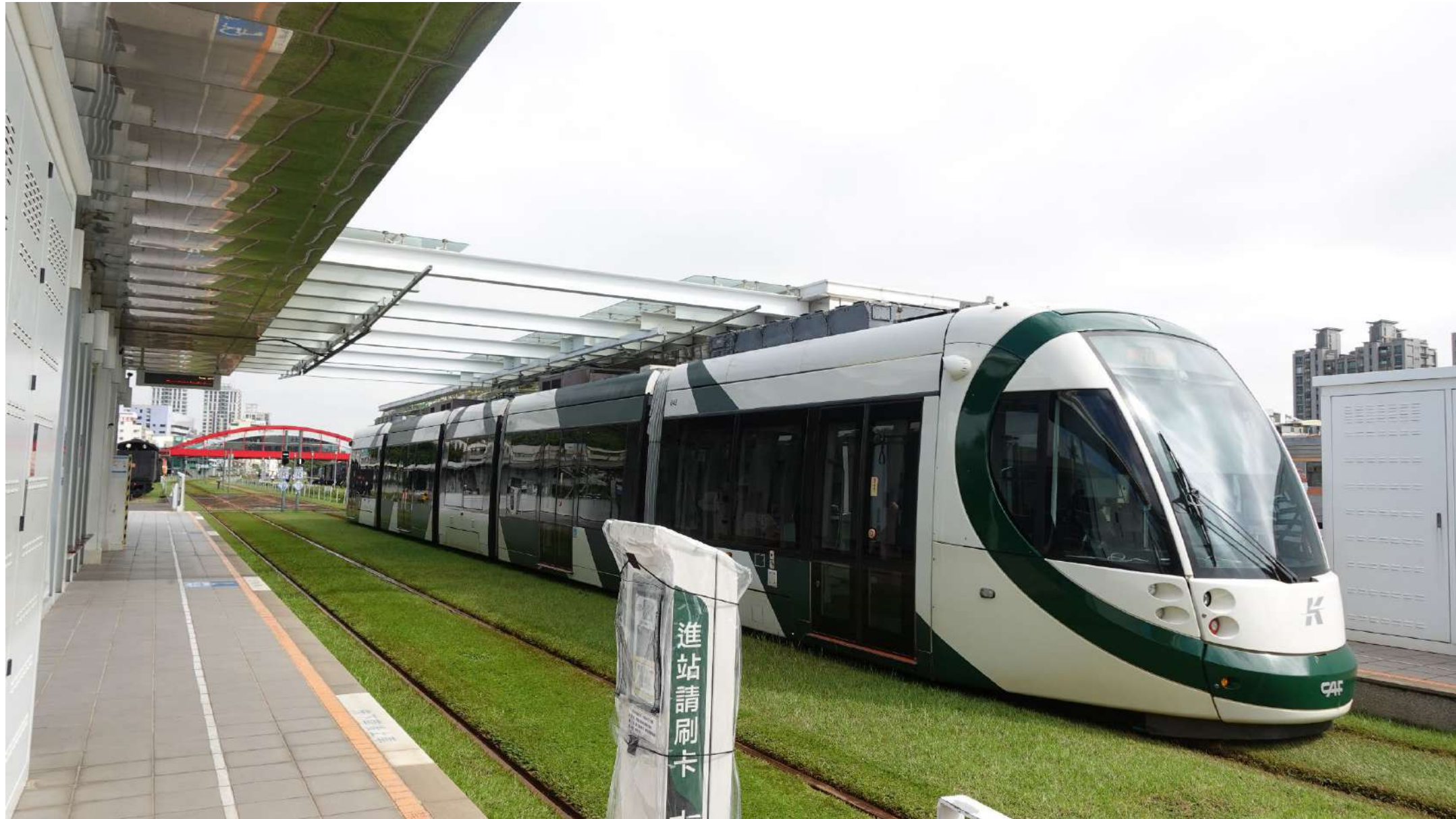
駅で停車中に上部のパンタグラフからトラムのキャパシターに充電する。
