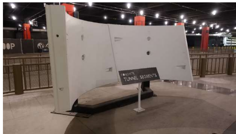
厚さ200mm程度長さ1m程度のコンクリートのセグメント
