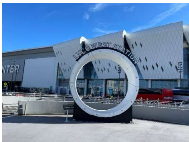
セグメントを繋げたもの直径約3.5m
